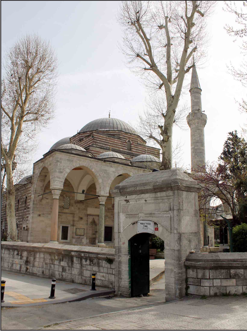
Murad Paşa Camii'nin Vatan Caddesi tarafındaki iç avlu kapısı.
