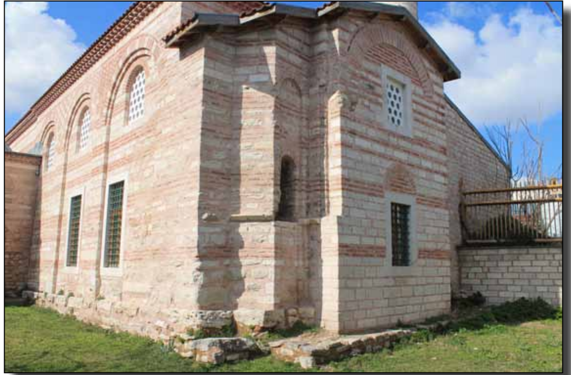
Eski mimari yapısına göre yeniden inşa edilen mescidin arkadan görünümü.
